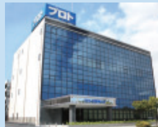
(株)プロトデータセンター本社ビル
